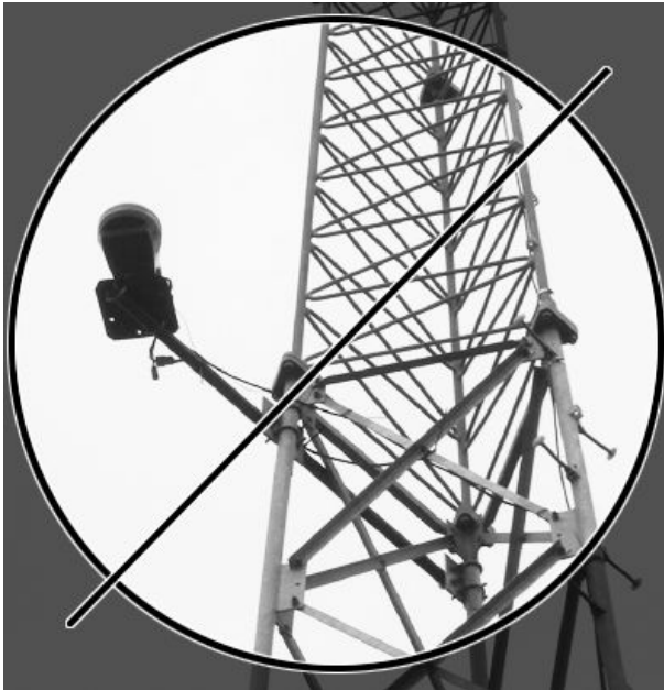
Récepteur sur un pylône radio
